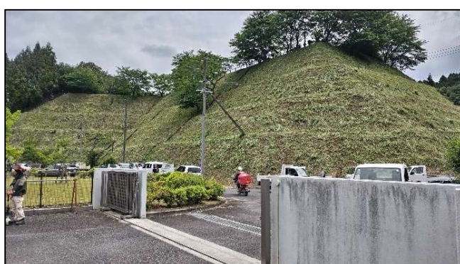
【ダム右岸法面 作業完了】
