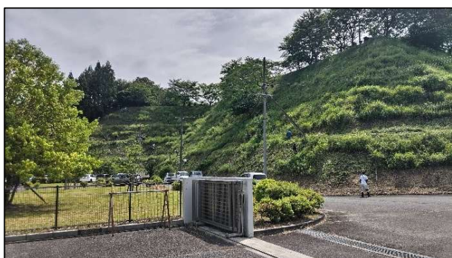
【ダム右岸法面 作業状況】
