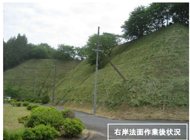
土舞台公園 作業状況
