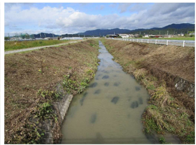
作業完了状況
