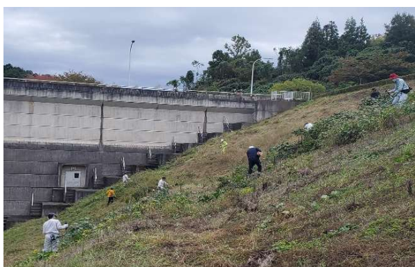
ダム左岸の草刈り
