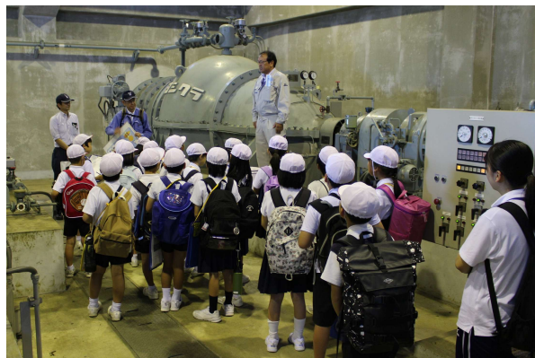
七区排水機場内でポンプのしくみを説明
