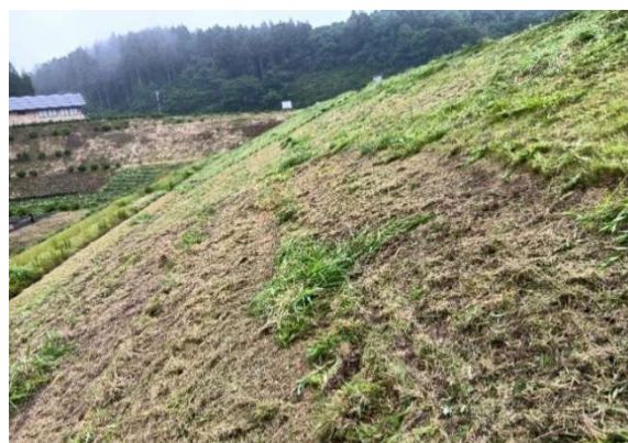
作業完了(右岸堤体)
