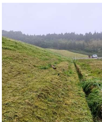
作業完了(左岸堤体)
