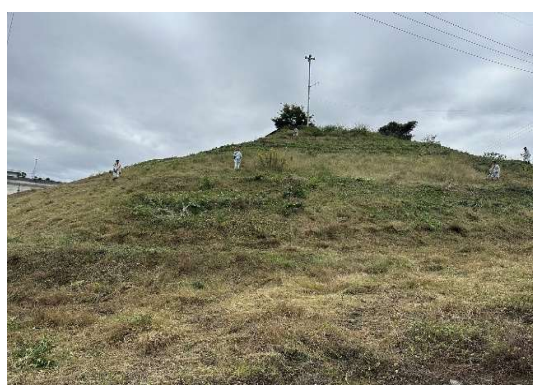
ダム左岸の草刈り
