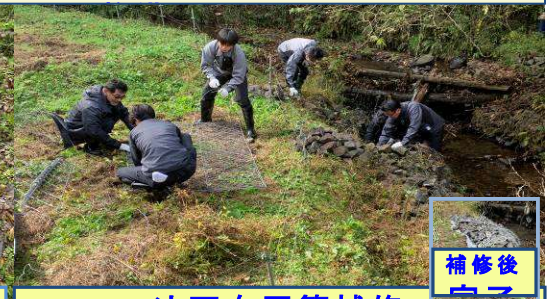
法面布団籠補修
