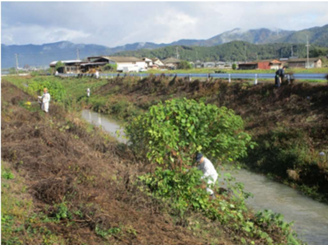
立木伐採作業
