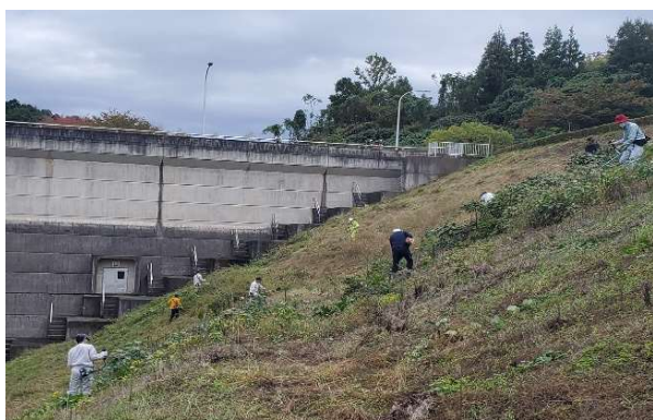
ダム左岸の草刈り
