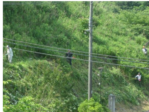
【ダム右岸法面 作業状況】
