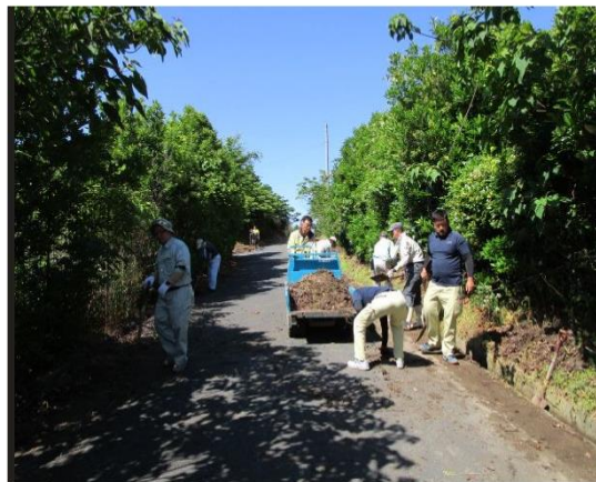
支線道路側溝泥上げ運搬状況
