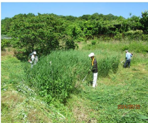
浦明団地沈砂池草刈り状況
