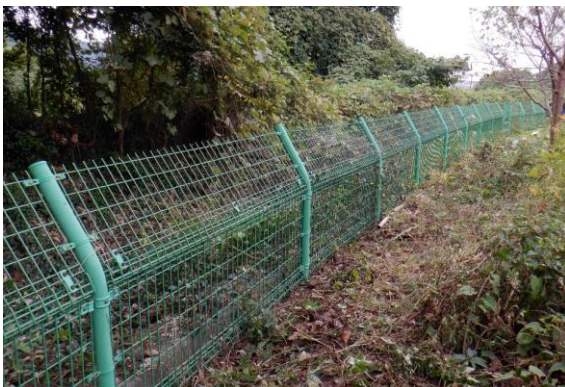
作業完了状況
