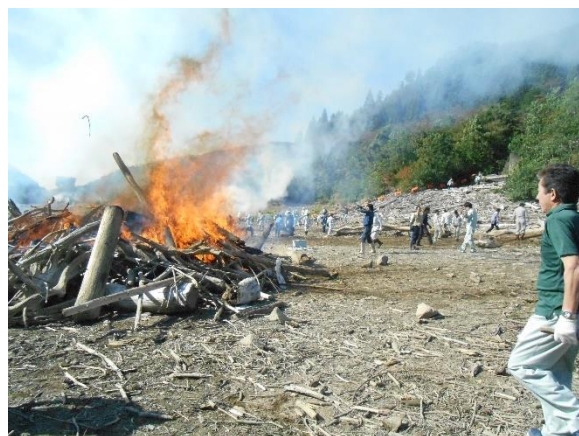
流木焼却作業状況
