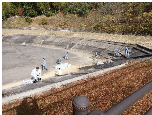
第2副堤洪水吐部の堆積土砂撤去
