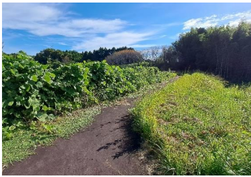
作業前 (本堤天端部)
