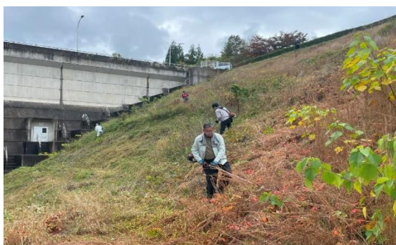
ダム左岸法面の草刈り
