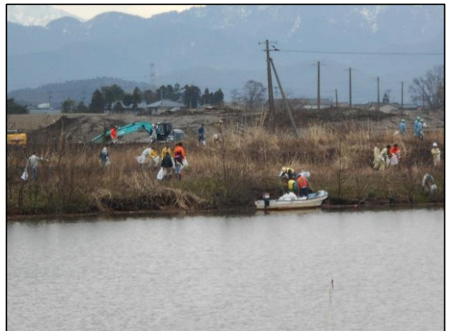
水陸連携の作業状況
