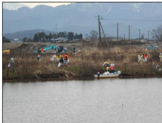
水陸連携の作業状況
