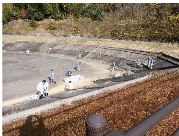
第2副堤洪水吐部の堆積土砂撤去
