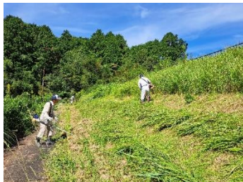
本堤除草状況
