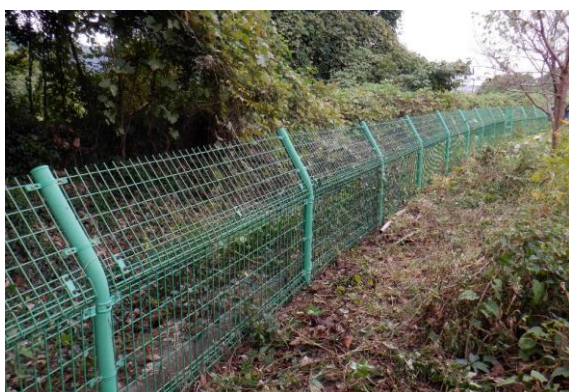
作業完了状況
