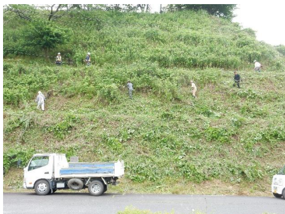
ダム右岸法面草刈り作業状況
