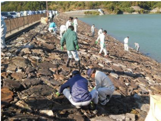
堤体貯水池側法面作業状況
