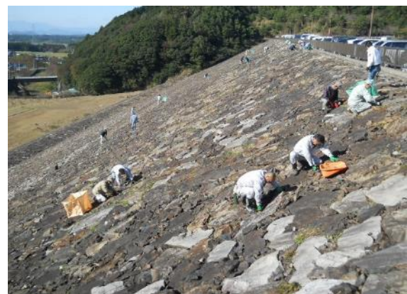
堤体下流側法面作業状況
