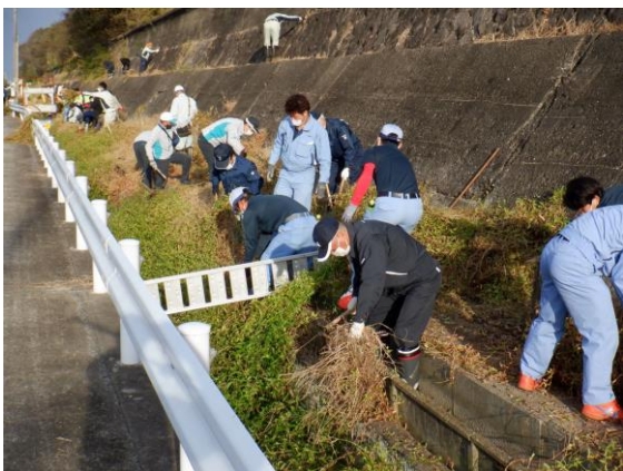
草刈りの作業状況
