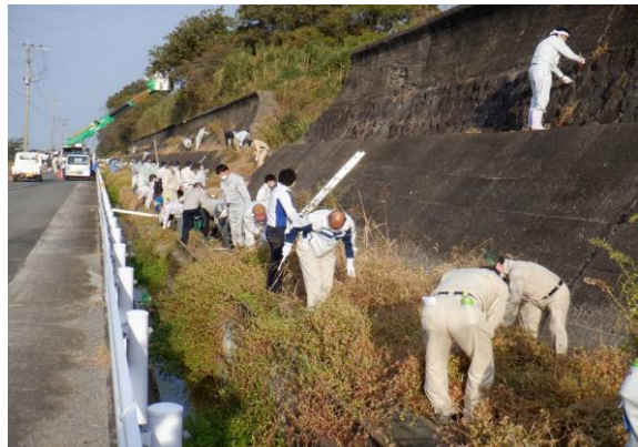
草刈りの作業状況
