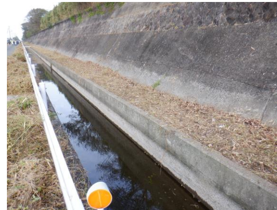
草刈りの作業完了
