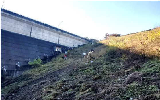
ダム左岸法面の草刈り
