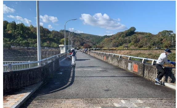
ダム天端道路
