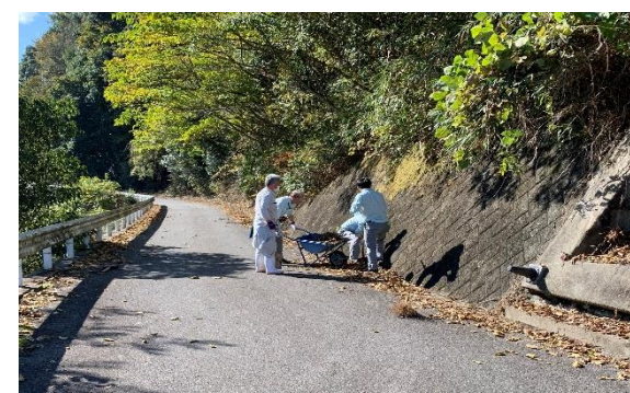
周回道路の泥上げ
