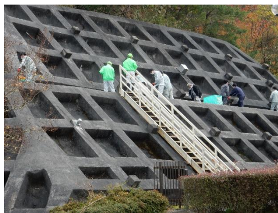
管理所横法面作業状況
