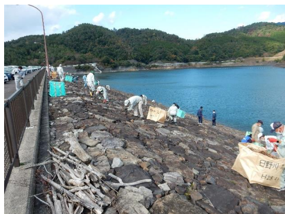
堤体貯水池側法面作業状況
