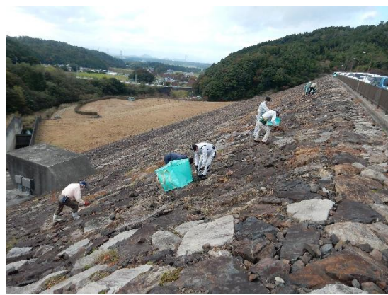
堤体下流側法面作業状況
