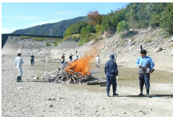
焼却作業状況(堤体付近)
