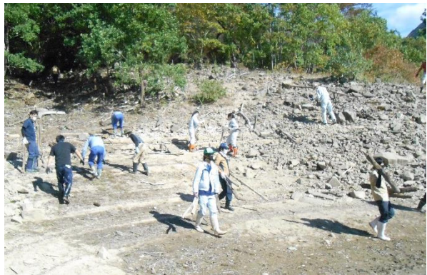
搬出作業状況
