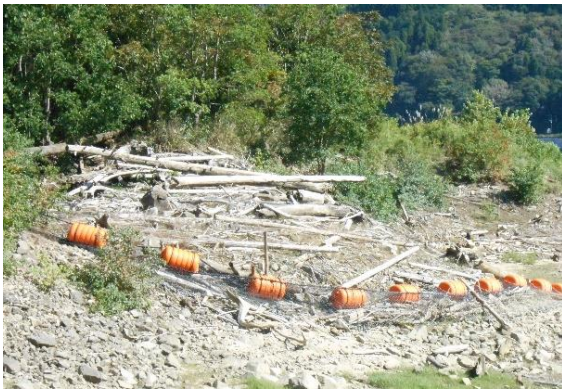
作業着手前(流木漂着状況)
