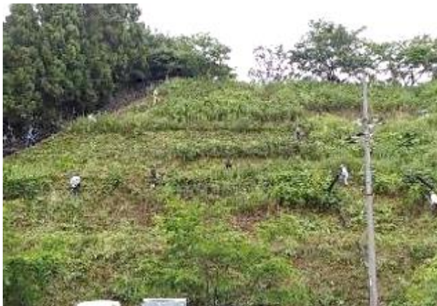
ダム右岸法面草刈作業状況
